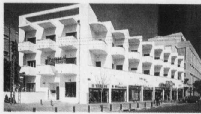
Rekanati House après restauration.
